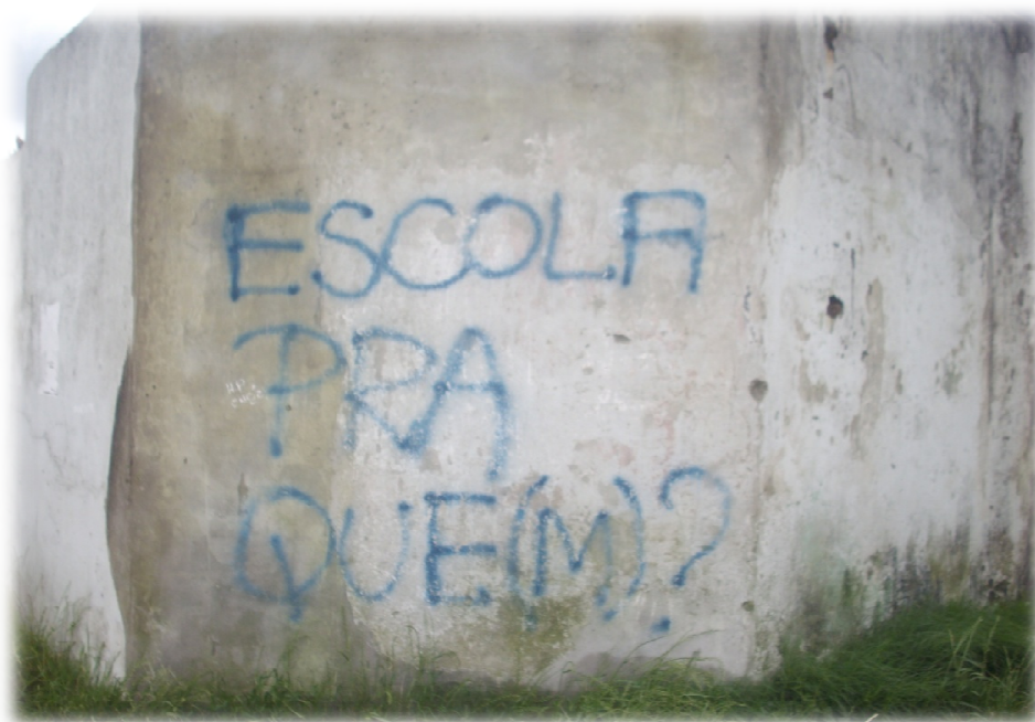
Figura 05 - Muro de uma escola pública na rua Domingos de Almeida – RG.
