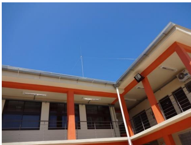
Figura 3.19: Antena de recepção do sinal do ondógrafo. FURG Campus São Lourenço do Sul.
