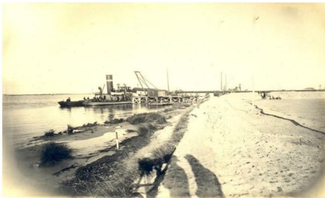
Figura 4: Terraplino Oeste Sedimentado para construção do Novo Porto
