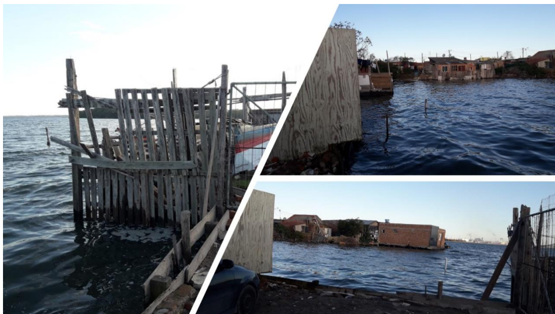
Figura 1. Sub-habitações no entorno do Saco da Mangueira (Bairro Lar Gaúcho).
