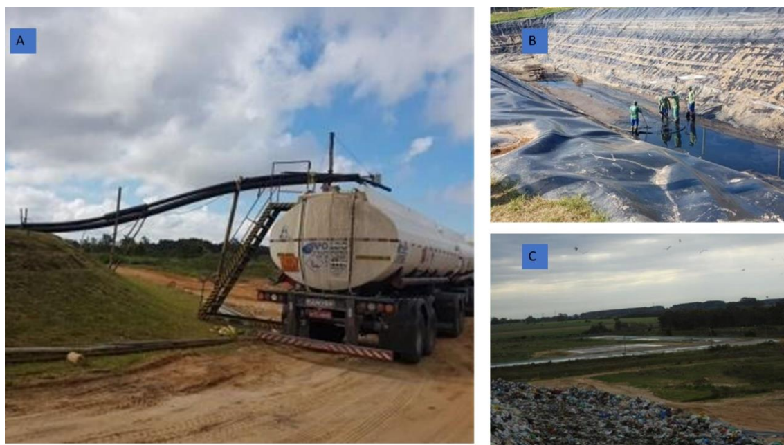
Figura 6. A) Vista de RSU dispostos na célula e lagoas ao fundo; B) Vista de uma das Lagoas sob manutenção; C) Exemplo de retirada do percolato gerado durante operação com empresa Rio Grande Ambiental.
