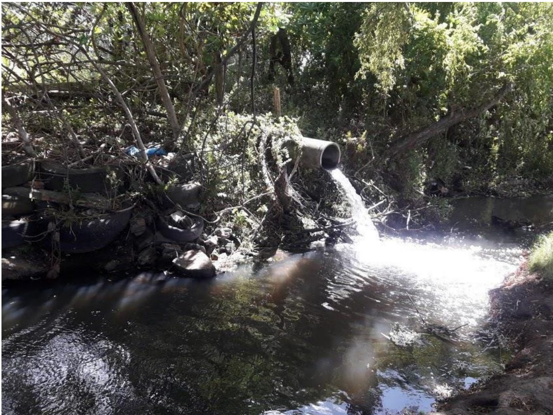
Figura 4 - Lançamento de efluente tratado da ETE do Bairro Parque Marinha no Arroio Vieira.
