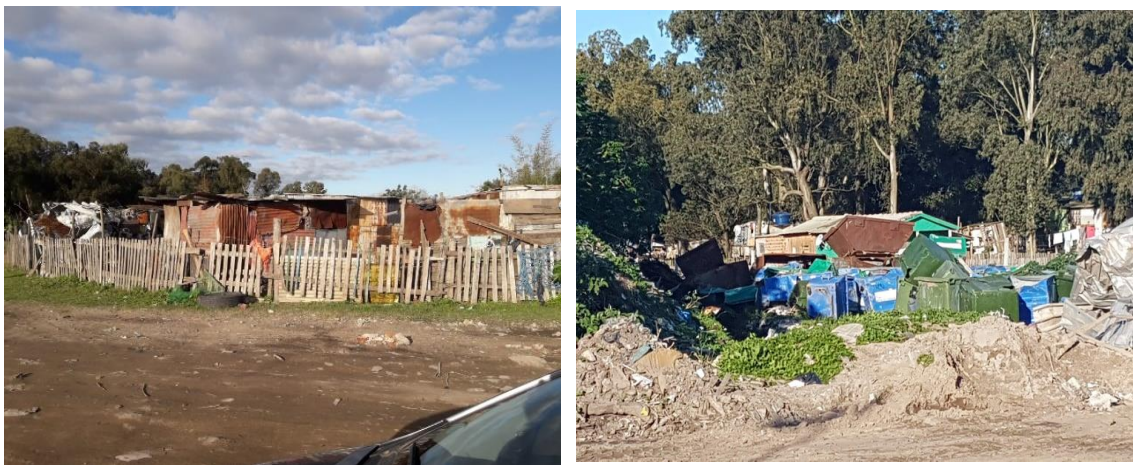
Figura 3. Habitações em área de risco ao lado do Antigo-lixão e “Bota-Fora”.
