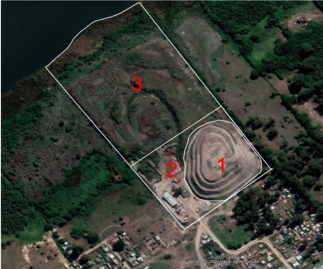
Figura 1. Imagem aérea do lixão municipal da cidade do Rio Grande, já desativado, localizado nas margens da enseada Saco do Martins, na Vila Maria dos Anjos, Bairro Carreiros, na margem da Estrada Roberto Socoowski. *Legenda: Área 1: Bota-Fora (2,3 hectares); Área 2: local de manobra e transbordo (4,3 hectares); Área 3: antigo lixão desativado (7,7 hectares). Imagem do Google Earth http://mapas.google.com . Consulta realizada em 04 de agosto de 2020.
