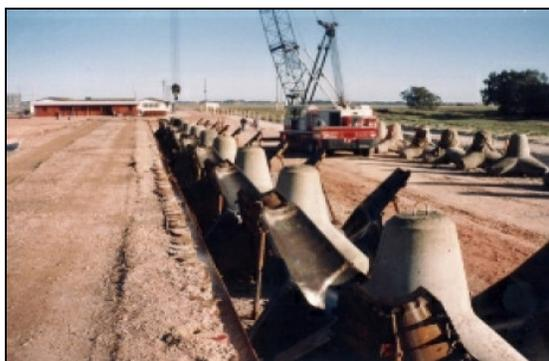
**Figura 7 - Canteiro de fabricação – Desfôrma [10].**
