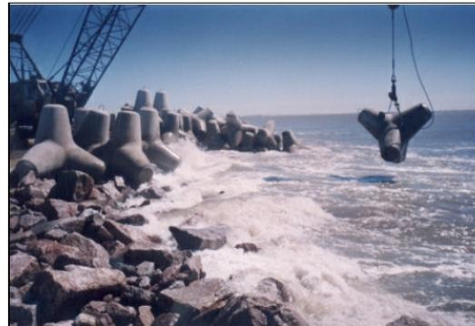
**Figura 12 Processo de alinhamento para colocação de um Tetrápode [10].**
