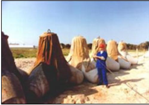
**Figura 9 - Tetrápodes em processo de cura úmida [11].**
