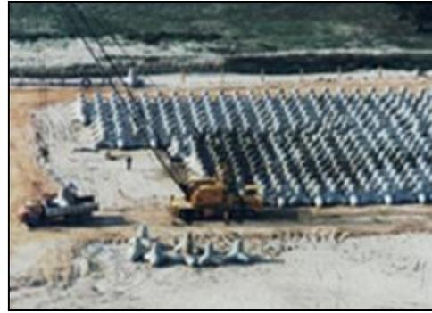
**Figura 10 - Tetrápode em condições de transporte para os molhes [10].**
