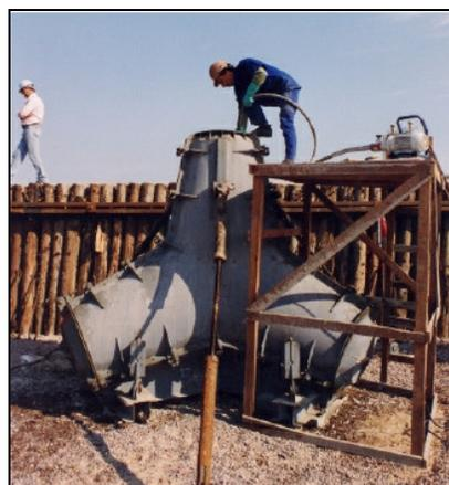
**Figura 8 - Vibração durante o processo de concretagem [10].**
