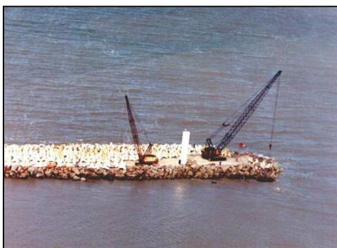
**Figura 6 - Instalação dos Tetrápodes no molhe leste [11].**
