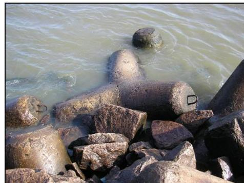
**Figura 18 - Fraturamento encontrado na junção das “pernas”.**
