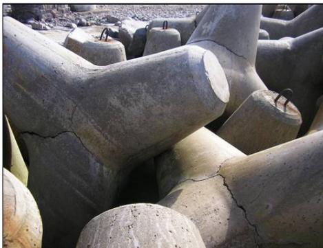
**Figura 20 - Blocos rachados interligados e sem pedras.**
