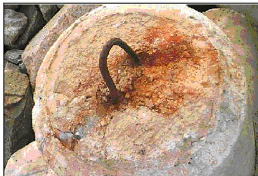
**Figura 15 - Fissuras junto à barra de aço [7].**
