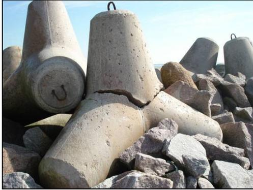
**Figura 16 - Tetrápode quebrado no lançamento.**
