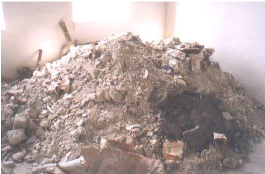
Figura 3.5 - Entulho de gesso gerado em um apartamento
