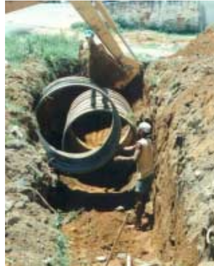
Figura 4.2 – Assentamento de tubo em compósito
