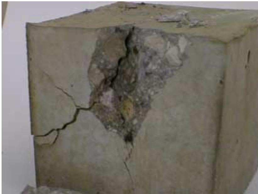
Foto 2. Detalle de la probeta de hormigón fisurada.
