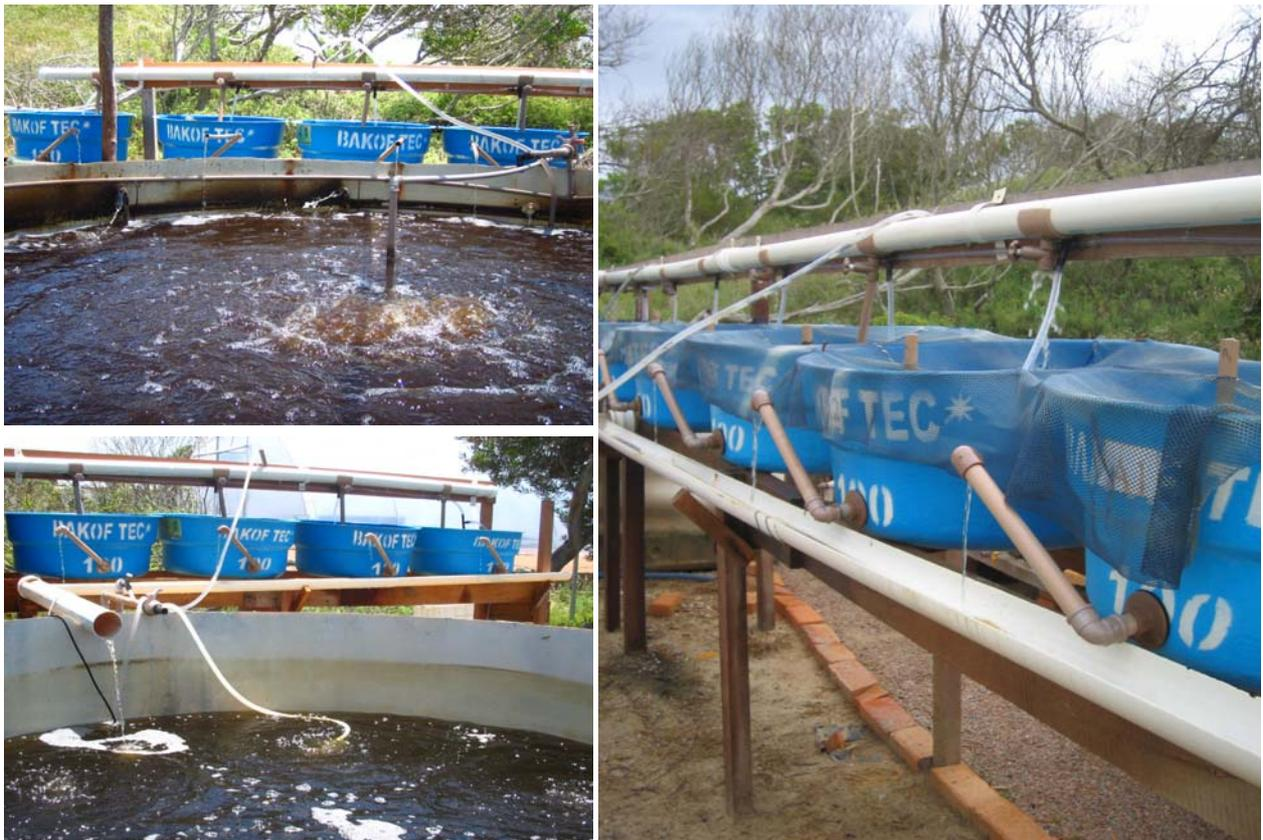
**Figura 4.** Sistema de recirculação nas unidades experimentais (tanques azuis): a água da respectiva matriz é bombeada até os tanques azuis, retornando por gravidade através de tubos de PVC e calhas.
