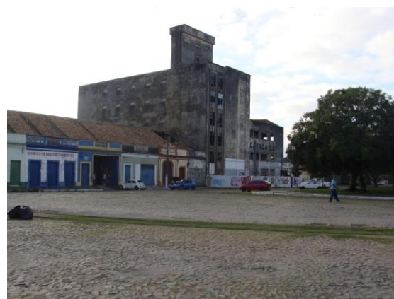
Figura 33. Foto do prédio da Cotada S/A, de posse da UFPEL. Fonte: do autor, 2011.
