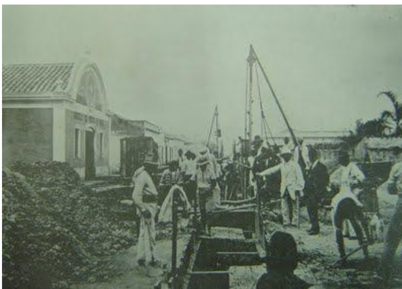
Figura 73. Construção da rede de esgotos de Pelotas em 1913. Fonte: imagenshistoricas.blogspot.com , acesso em março de 2011.
