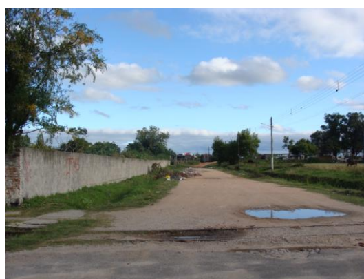
Figura 28. Foto da falta de saneamento. Fonte: do autor, 2011.
