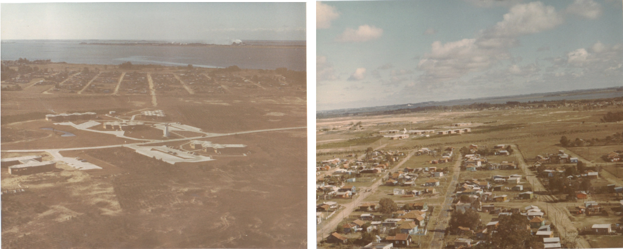
Figura 8: Imagens aéreas do campus Carreiros da FURG com a Vila Maria ao fundo na imagem da esquerda e em primeiro plano na imagem da direita/ década de 1970. Fonte: Núcleo de Memória Engenheiro Francisco Martins Bastos - NUME/FURG.
