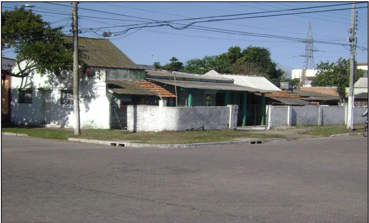
Foto1: A vista da estrutura externa do prédio do CERSJ.
