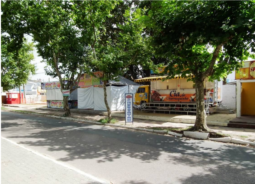
Fotografia 54: Palacete Barbará após demolição total. Atualmente o terreno encontra-se ocupado por trailers e quiosques. Fonte: Fabrício Pomar, 2010.
