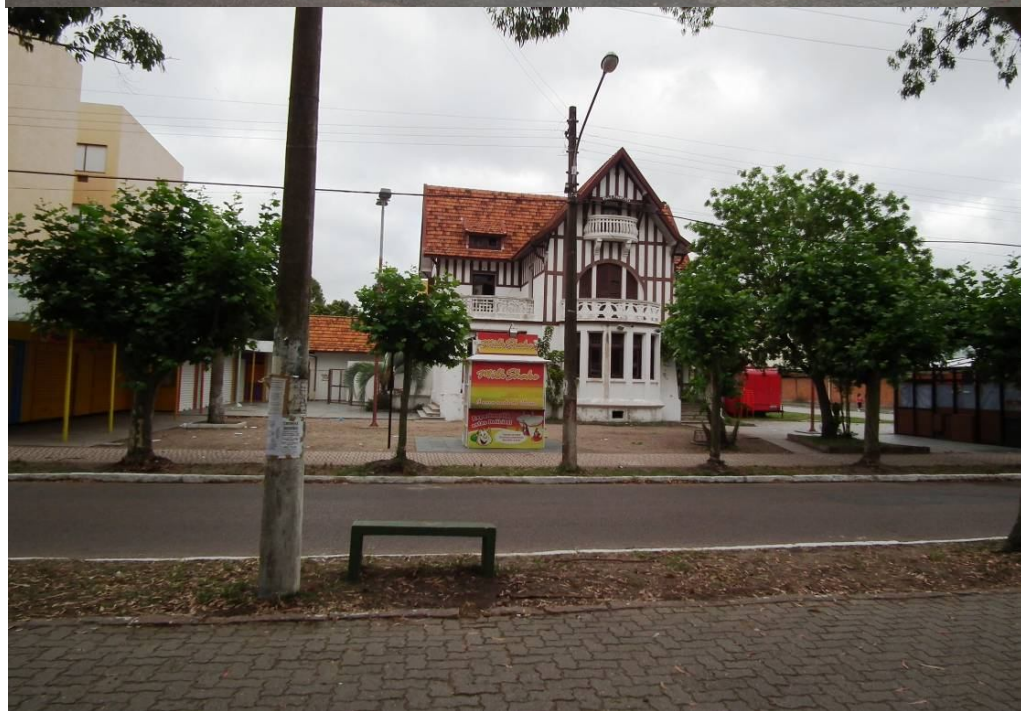
Fotografia 12: Os recuos laterais e de ajardinamento do lote substituídos por quiosques e trailers de lanches. Fonte: Fabrício Pomar, 2010.
