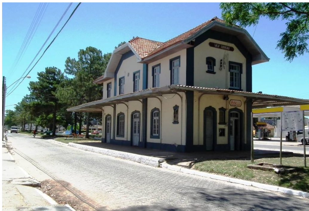
Fotografia 49: Prédio da antiga Estação Férrea Villa Sequeira com nova pintura externa. Fonte: Fabrício Pomar, 2010.
