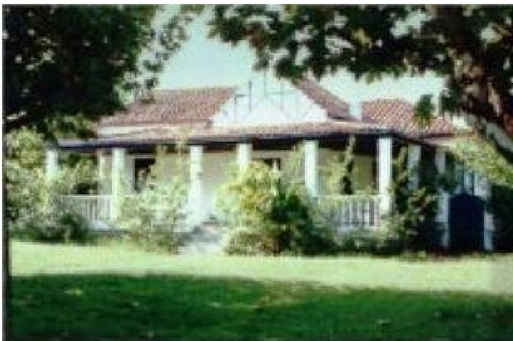
Figura 70: Residência de Abel Dourado antes de ser demolida para construção de um prédio de seis pavimentos, s.d. Fonte: Leivas Otero, 2010.
