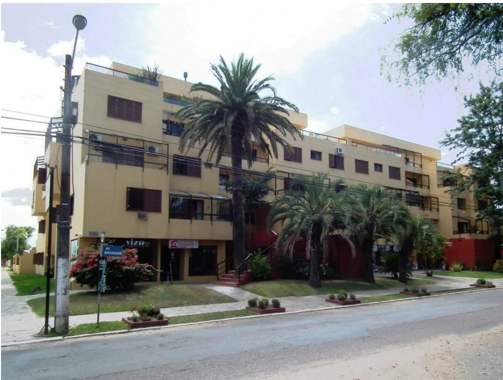
Fotografia 56: Edifício Villa Siqueira composto por lojas no pavimento térreo. Fonte: Fabrício Pomar, 2010.
