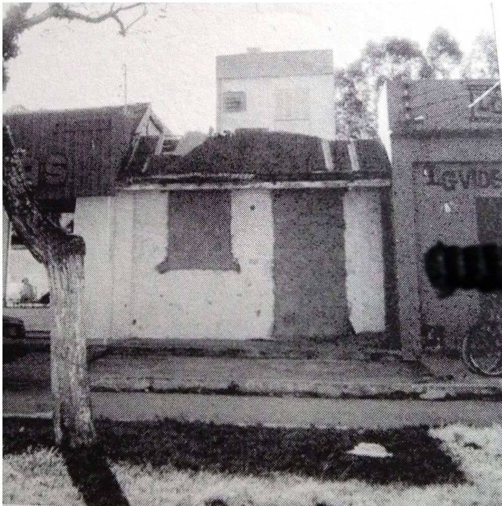
Figura 60: Alterações na fachada, Rua Oswaldo Cruz, 1996. Fonte: Célia Pereira, 1996.
