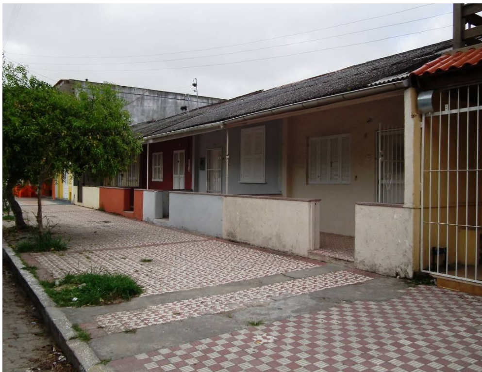
Fotografia 19: Atualmente algumas casas geminadas que formavam o 'Quadro' pela Rua Oswaldo Cruz, 2010. Fonte: Fabrício Pomar, 2010.
