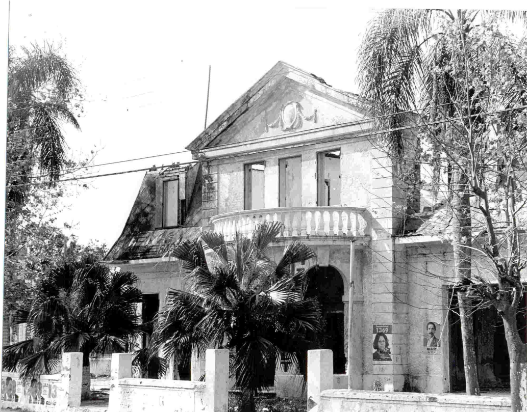
Figura 68: Abandono após início de demolição interrompida por embargo judicial. Fonte: Rio Grande em Fotos, s.d.
