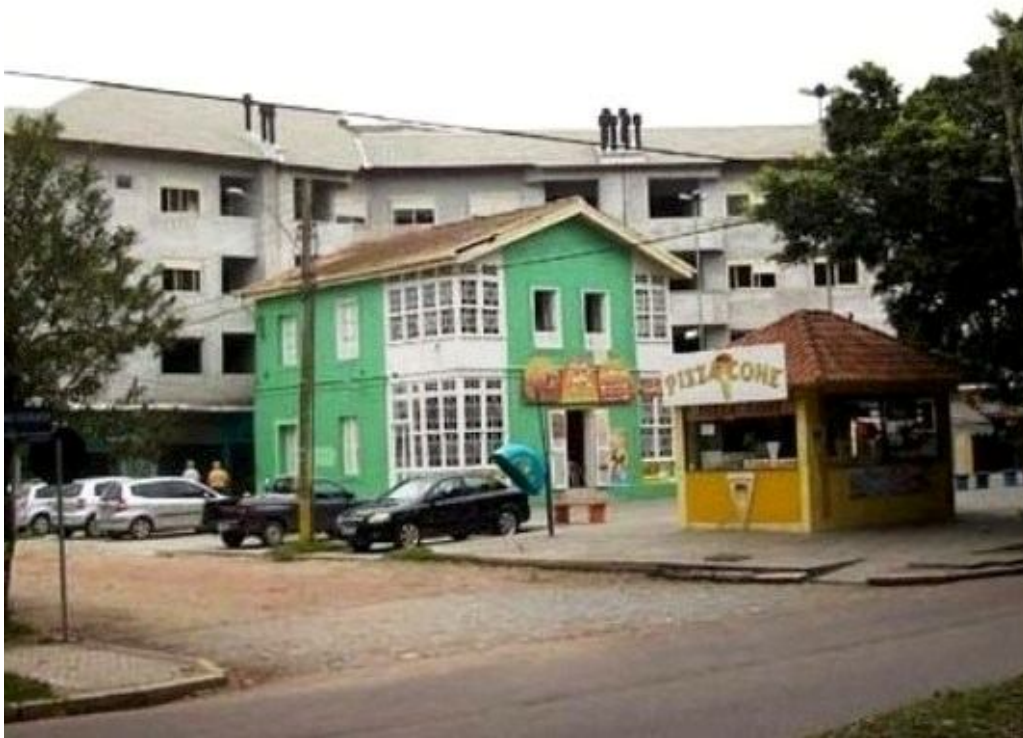
Fotografia 03: Sorveteria Zum-Zum instalada na antiga colônia de férias da Viação Férrea. Ao fundo, edifício de quatro pavimentos em conclusão, 2009. Fonte: Fabrício Pomar, 2009.
