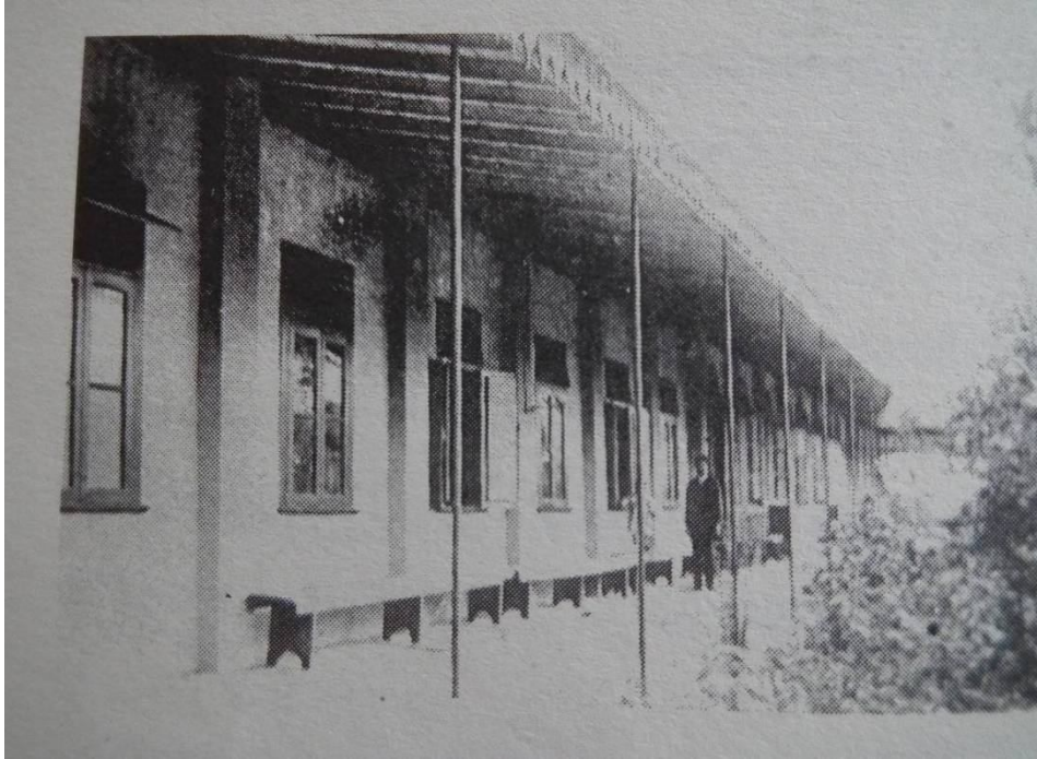
Figura 26: Avarandado dos salões de jogos, bailes e refeições, em frente à Rua República, 1908. Fonte: Acervo Museu Histórico da Cidade, 2005.
