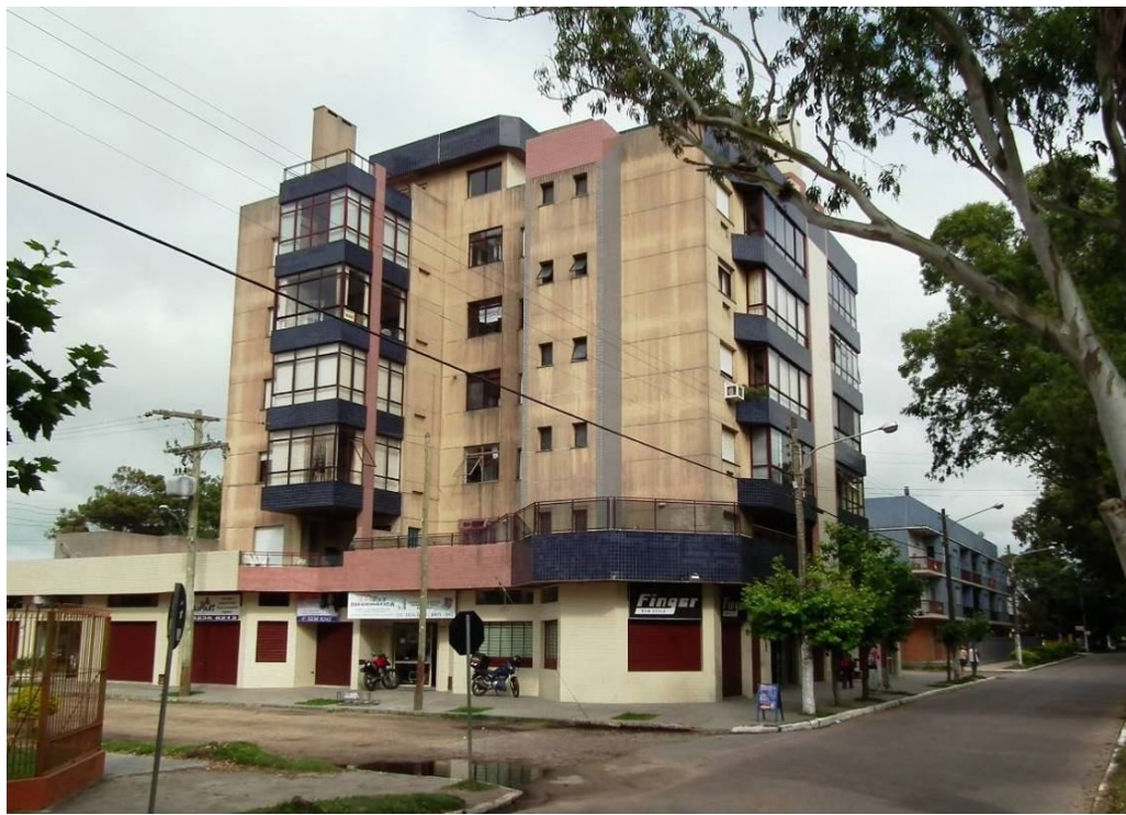
Fotografia 65: Tendência de verticalização da Avenida Rio Grande nos espaços antes ocupados pelos casarões. Prédio no alinhamento do passeio público com perdas no recuo de jardim. Fonte: Fabrício Pomar, 2010.
