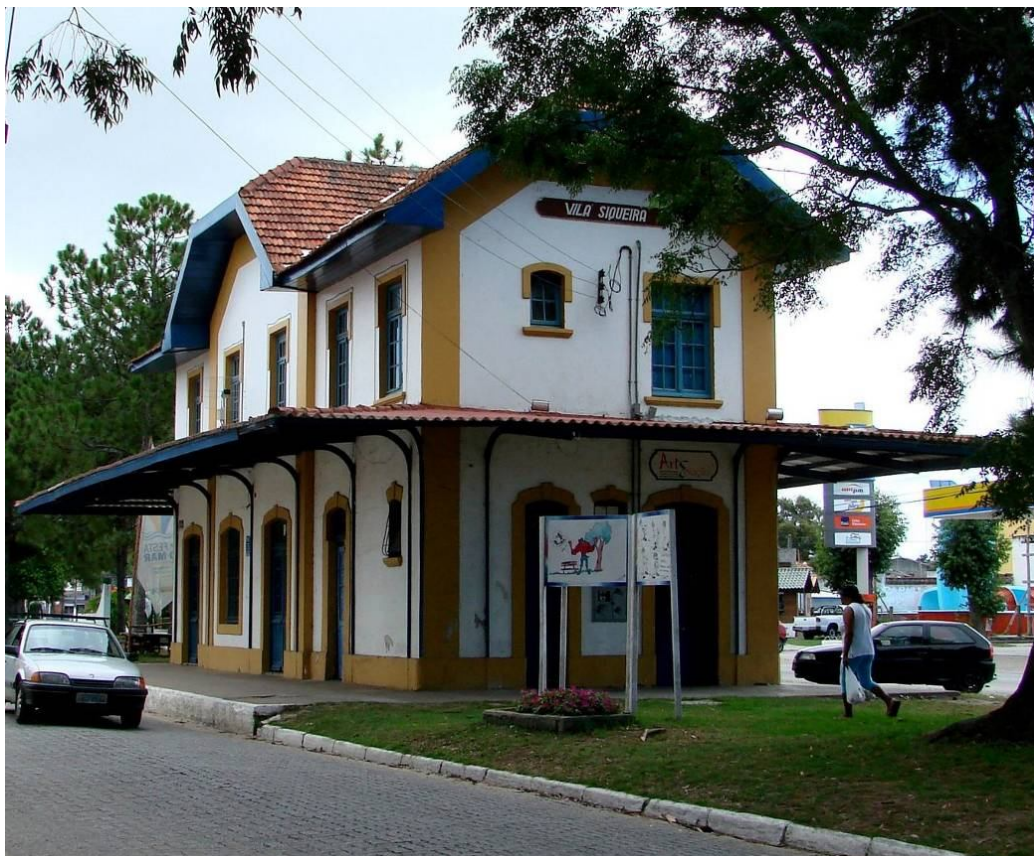
Fotografia 48: Prédio da antiga Estação Férrea após reforma (atual ONG ArtEstação). Fonte: Fabrício Pomar, 2005.
