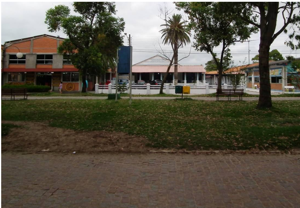
Fotografia 17: Cassino Hotel (antigo chalet Luchsinger) em 2010. Descontextualização do entorno da edificação principal. Fonte: Fabrício Pomar, 2010.
