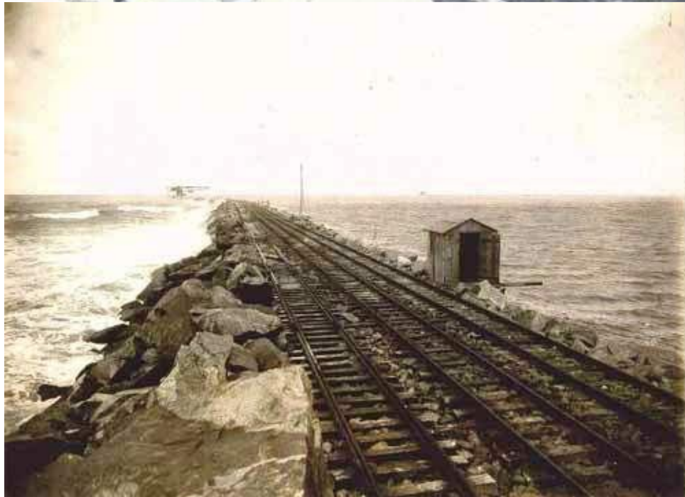
Figura 12: Construções dos Molhes da Barra do Rio Grande. Fonte: Rio Grande em Fotos, 2010.
