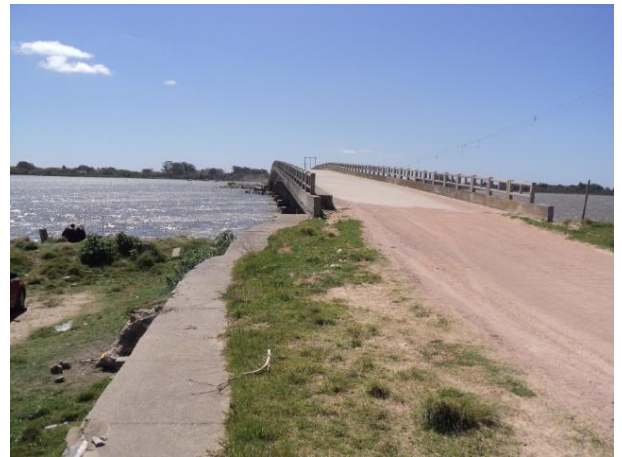
FIGURA 11 - Vista da ponte
