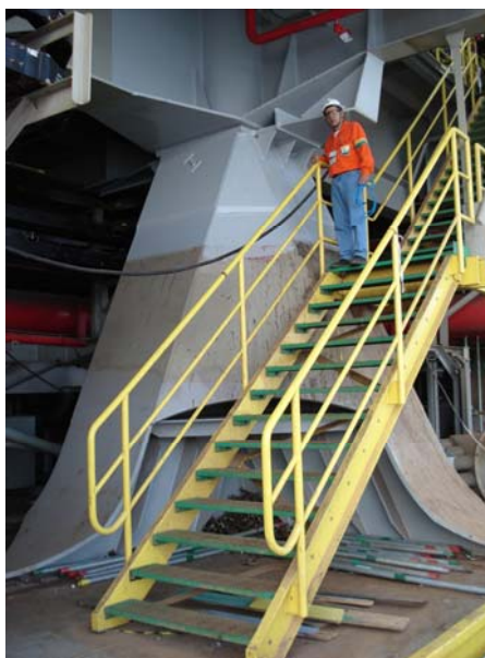
Figura 3.6 – Stool deslizando da plataforma P-54
