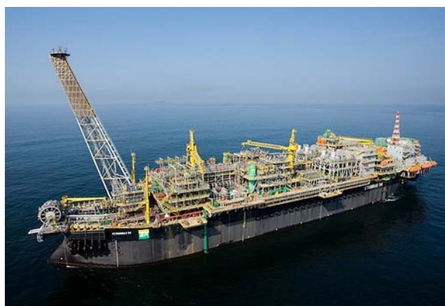
Figura 2.10 – FPSO P-54 (Bacia de Campos)
