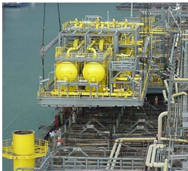
Figura 3.5 – Suportes treliçados sob o módulo içado
