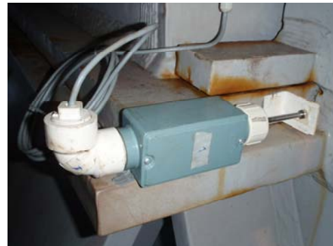
Figura 5.6 – Instalação do LVDT em um stool deslizante
