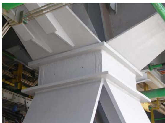
Figura 3.10 – Detalhe do topo do stool do tipo fixo da plataforma P-53
