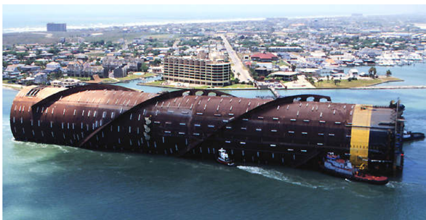
Figura 2.9 – Estrutura de flutuação da plataforma SPAR (Gênesis)
