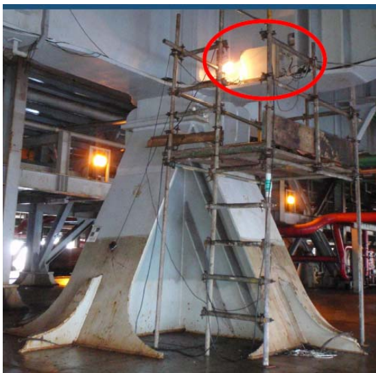
Figura 5.9 – Localização da caixa de interligação dos sensores (amplificadores)
