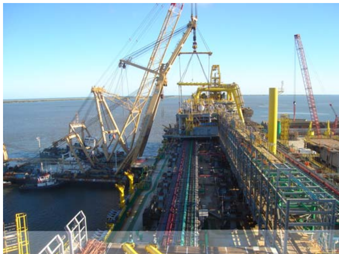
Figura 3.4 – Operação de içamento de um módulo (P-53)
