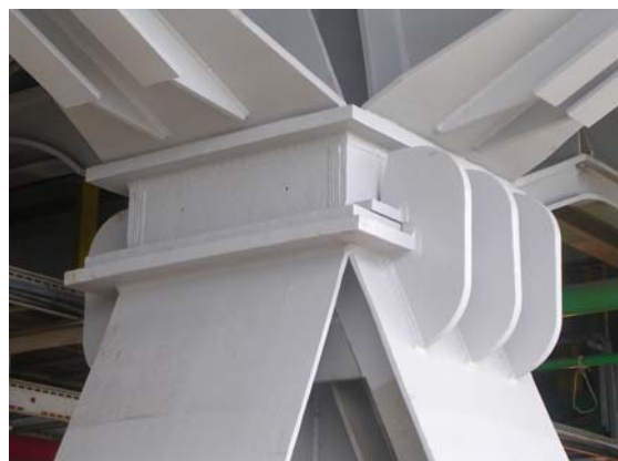
Figura 3.11 – Detalhe do topo do stool do tipo deslizante da plataforma P-53
