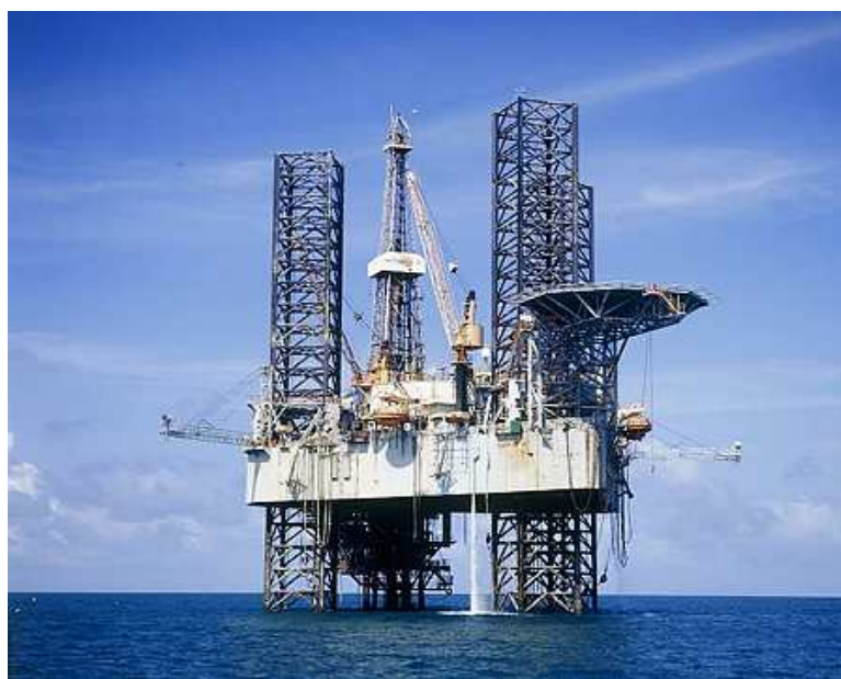
Figura 2.4 – Plataforma auto-elevável P-6 (Litoral de Sergipe)
