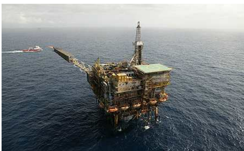
Figura 2.2 – Plataforma fixa Pampo (Bacia de Campos)
