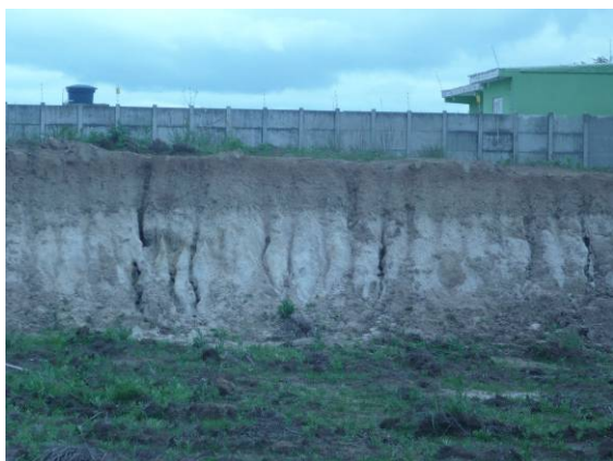
Figura 7.31 – Perfil do solo da unidade PLpl2. Processos erosivos no solo da unidade PLpl2. Ponto v4p2.
