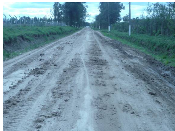
Figura 7.27 – Vias de acesso não pavimentadas ao interior da porção noroeste do Vazio 3. Unidade PLpl2. Ponto v3p2.
