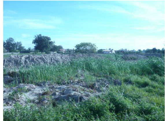
Figura 7.64 – Movimento de terra para implantação de Shopping Center em área do Vazio 13. Ponto v13p2.
