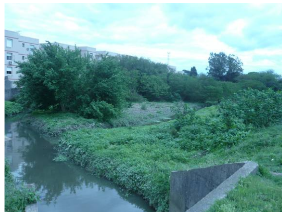
Figura 7.30 – Canal de drenagem existente no local. Ponto v4p1.
