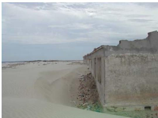
**Figura 70-** a) e b) Fotografias da escola que foi soterrada devido ao ativo transporte eólico próximo do molhe. c) Seta indica detalhe da estrutura que se prolonga até o pós-praia.
