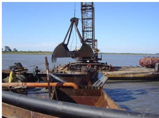
Figura 2.3- Dragagem de aprofundamento do Porto Novo 2.
