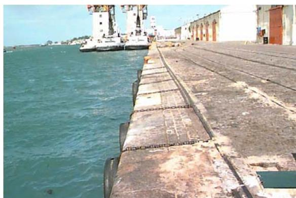
Figura 4.4 - Região do Cais do Porto Velho com Avaria - Observa-se curvatura dos trilhos 2 – Dias et al (2000).
