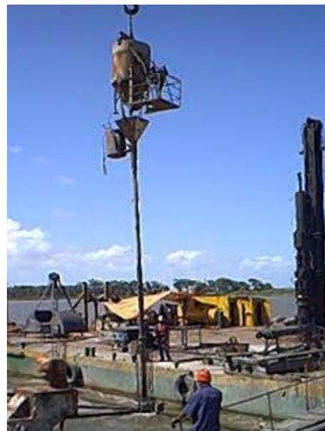
Figura 5.10 - Concretagem da estaca 2.
