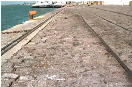
Figura 4.5 - Linha de Ruptura e recalque do pavimento – Dias et al (2000).
