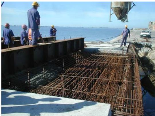
Figura 5.22 – Concretagem do bloco.
