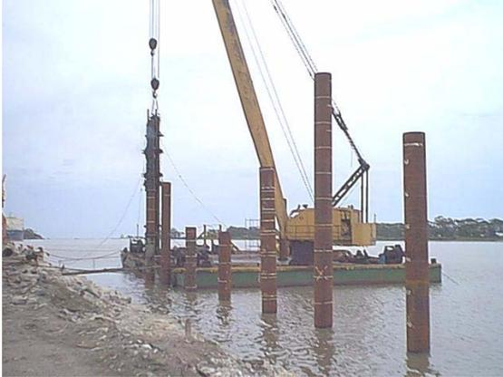
Figura 5.6 – Cravação do tubo metálico.
