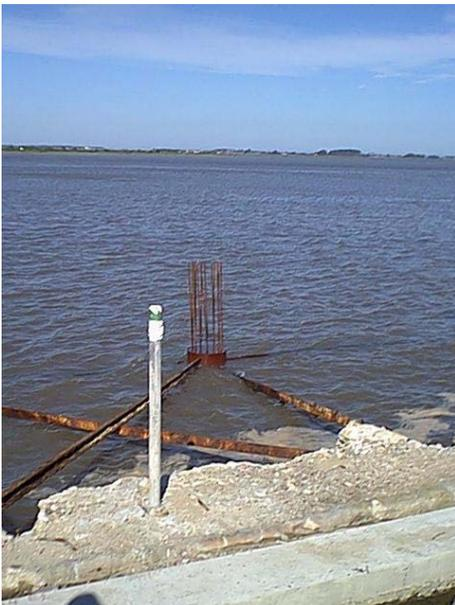
Figura 5.8 – Armação das estacas.
