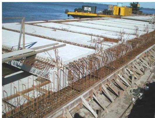
Figura 5.19 – Armadura da viga V2.
