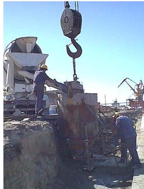
Figura 5.9 – Concretagem da estaca 1.
