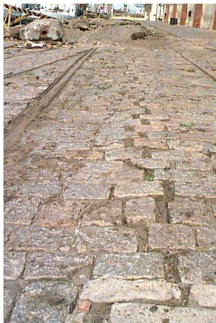
Figura 4.6 - Linha de ruptura ao longo do pavimento – Dias et al (2000).
