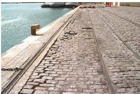
Figura 4.9 - Linha de ruptura junto ao muro -
