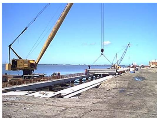
Figura 5.21 – Montagem da laje Pi.
