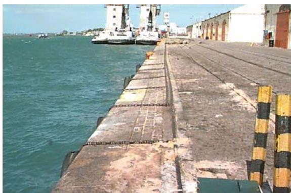
Figura 4.3 - Região do Cais do Porto Velho com Avaria - Observa-se curvatura dos trilhos 1 – Dias et al (2000).
