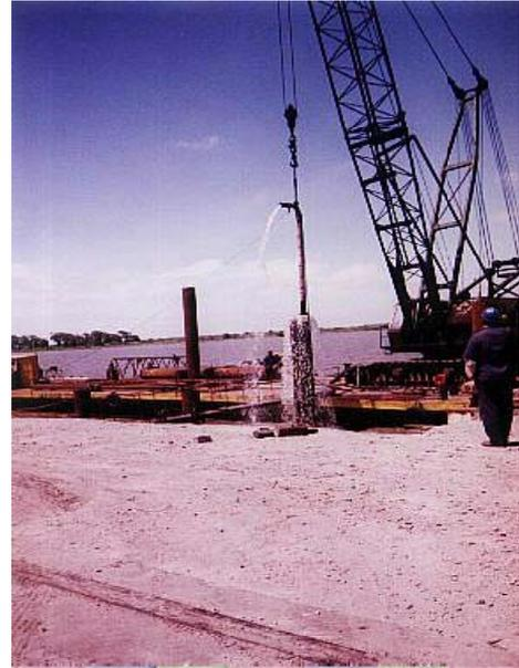
Figura 5.7 – Limpeza do interior das Estacas.
