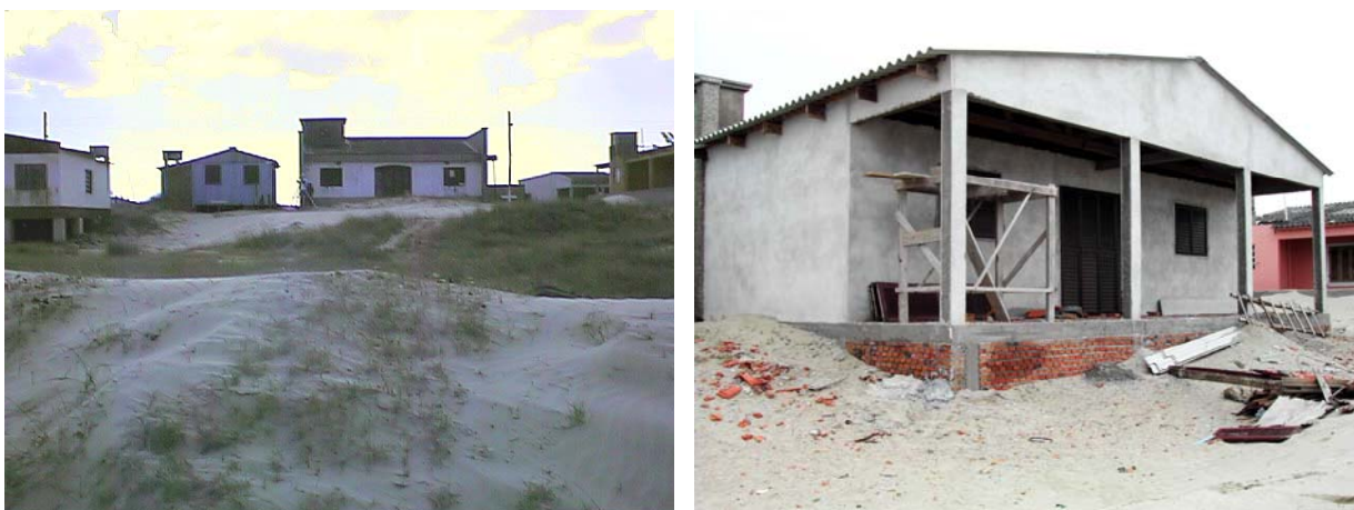
Figura 2.7 – Localização do perfil praia realizado na seção “D” e as obras realizadas na casa.
