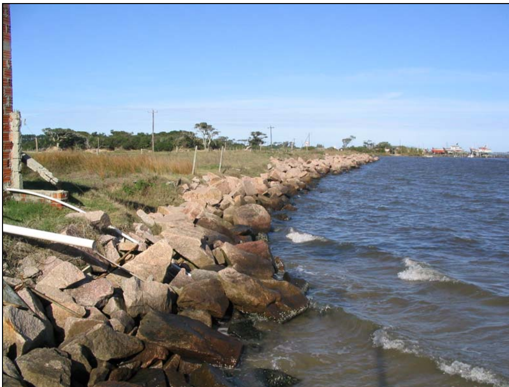
Figura 3.4 – Enrocamento de pedras para proteção da margem.
