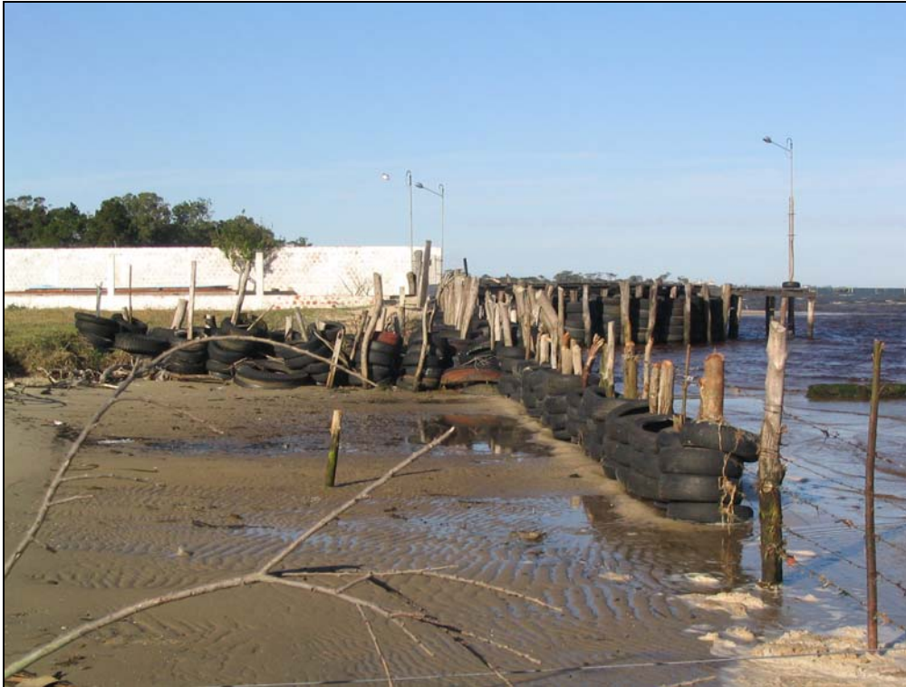
Figura 3.5 – Proteção da linha de costa com paliçadas e pneus.
