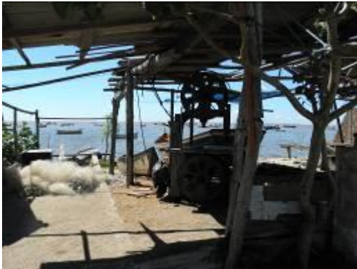
Figura 25 - Estaleiro em atividade, mas sem serviço no momento
