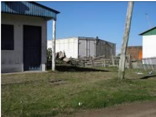
Figura 21 - Estrutura para refrigeração de pescado
