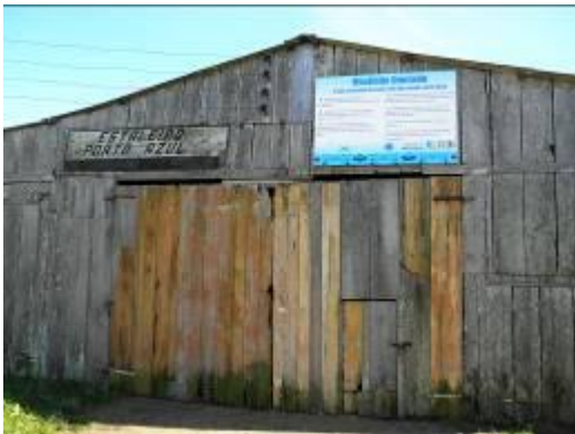
Figura 19 - Placa em galpão – iniciativa de Educação Ambiental
