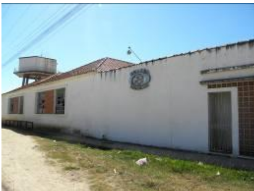
Figura 23 - Estrutura da antiga fábrica de beneficiamento de pescados (Solisa) - desativada
