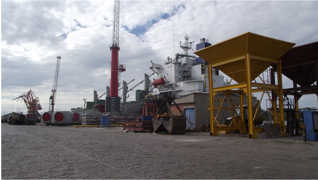
Figura 2. Área de Operações do Porto Novo.
