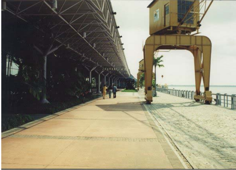
Figura 1 - "Estação das Docas" com os guindastes antigos restaurados.
