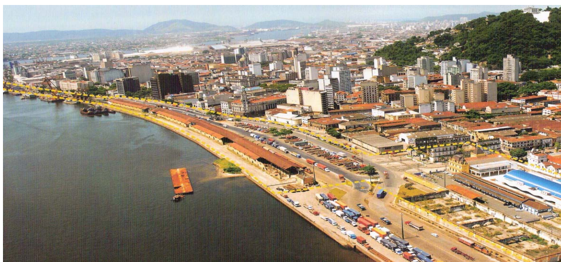
Figura 4 - Oito armazéns que fazem parte do complexo a ser revitalizado.
