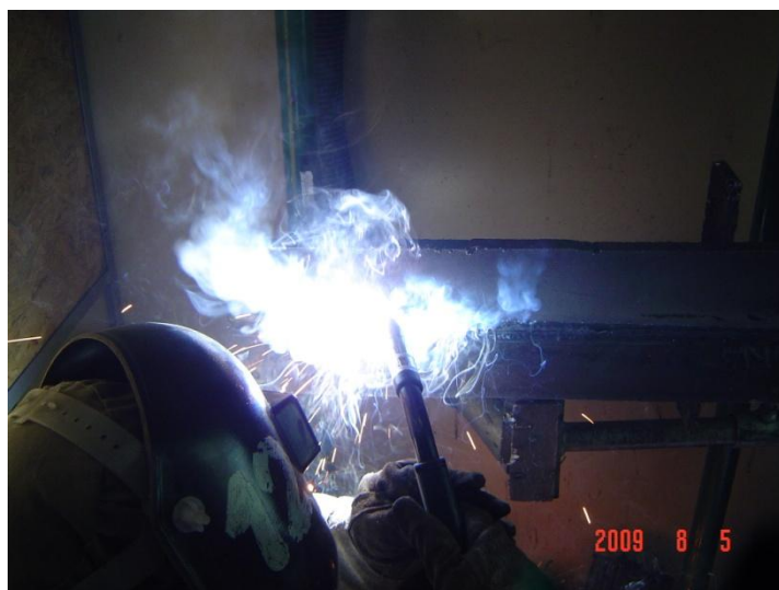
Figura 1 – Processo de soldagem a arco elétrico.
