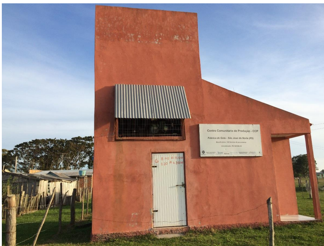
Imagem 14: Fotografia do Centro Comunitário de Pescadores e Agricultores da Localidade da Várzea.
