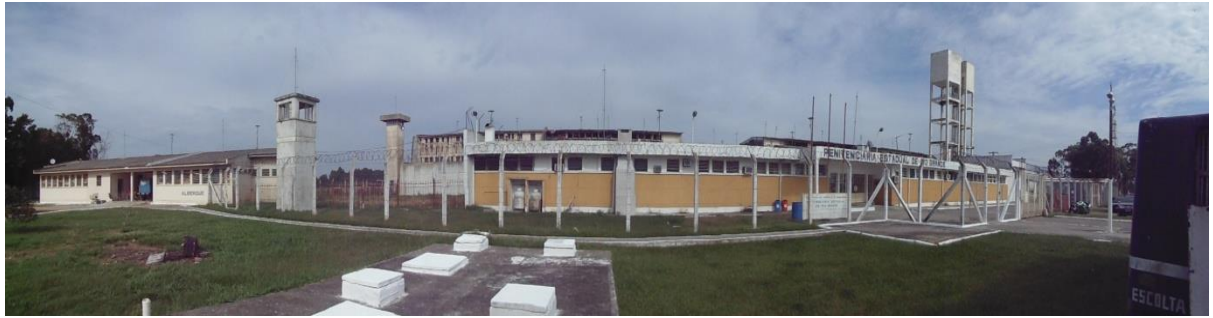
Figura 1 - Vista externa da PERG
