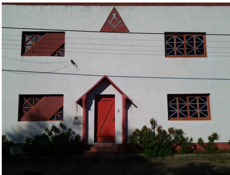
Figura 30: Prédio da Maçonaria (2013)
