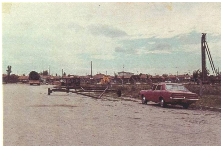
Figura 6: Estrutura de transporte utilizada na locomoção das casas removidas, denominada como triângulo. Dezembro de 1972.
