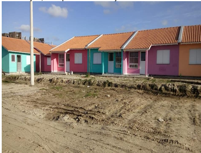
Fotografia 26: Moradias do Junção, com pintura externa já realizada
