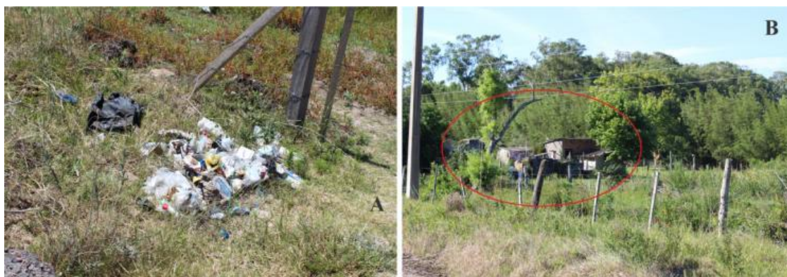
Figura 52 – Descarte de lixo (A) e ocupação indevida na APA da Lagoa Verde (B).
