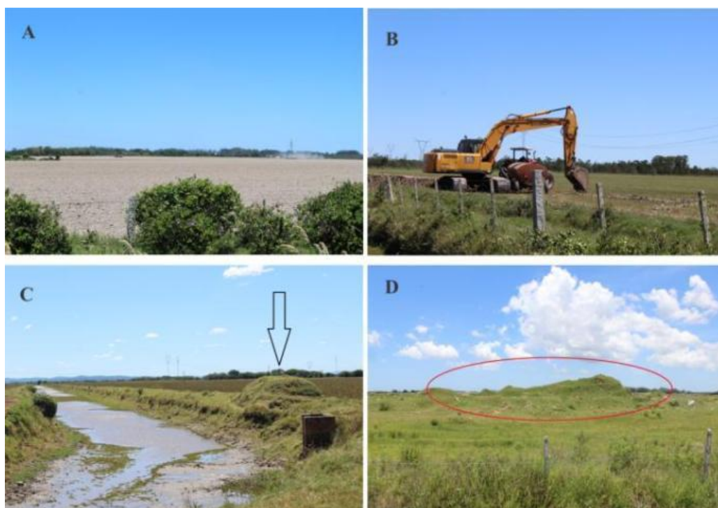
Figura 44 —Preparo do terreno com retirada da vegetação nativa (A), maquinário utilizado na abertura de canais (B) e novas morfologias geradas (C e D).
