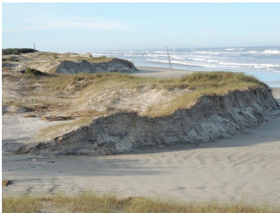
Figura 34. Escarpas nas dunas frontais do balneário Mostardense em 8 de julho de 2016.
