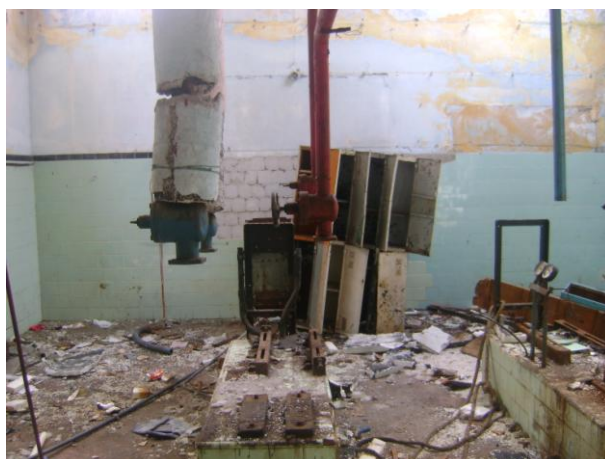
Figura 12 - Equipamentos destruídos no interior da indústria Moura
