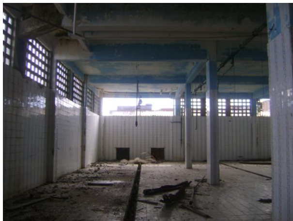
Figura 11 - Interior em ruínas da indústria Moura em São José do Norte
