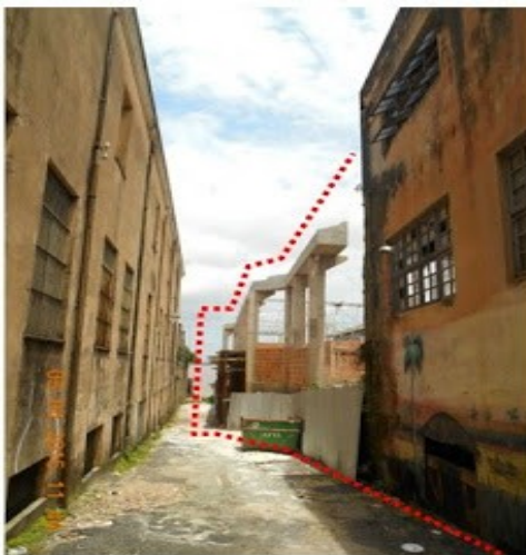
Fotografia 3 – Estreitamento da Travessa Félix Rocque e obstrução do acesso à Baía do Guajará
