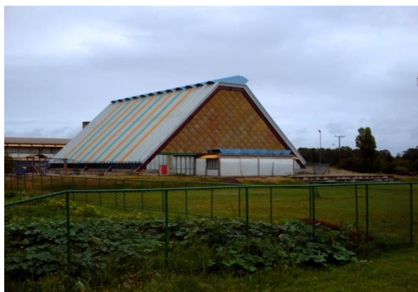
Figura 08: Prédio do CAIC/FURG
