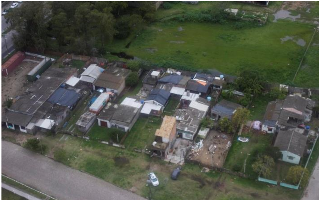
Fonte: Coordenadoria Municipal de Proteção e Defesa Civil do Rio Grande, 2015.
