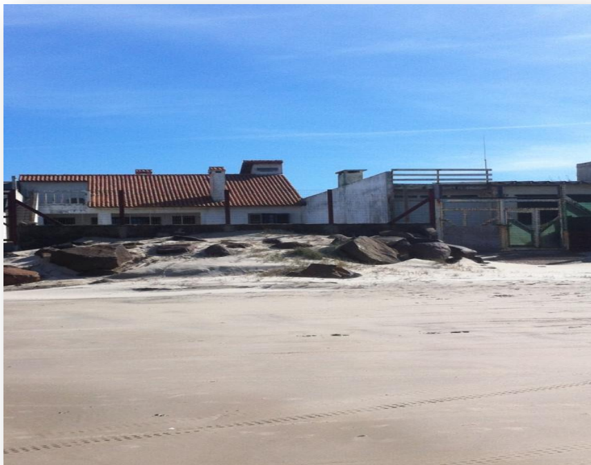
Figura 6 : Estruturas de contenção recobertas por areia e vegetação (2015).
