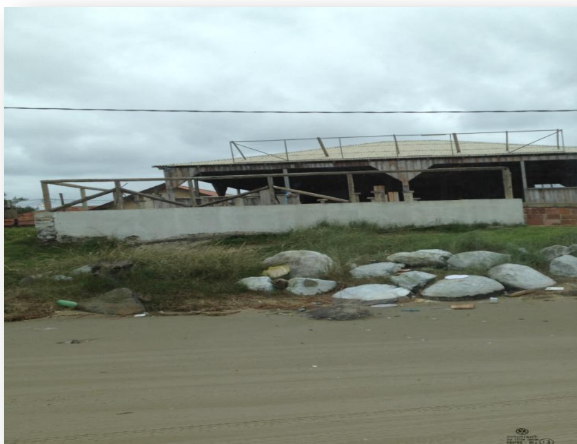
Figura 5: Estruturas de contenção recobertas por areia e vegetação (2015).
