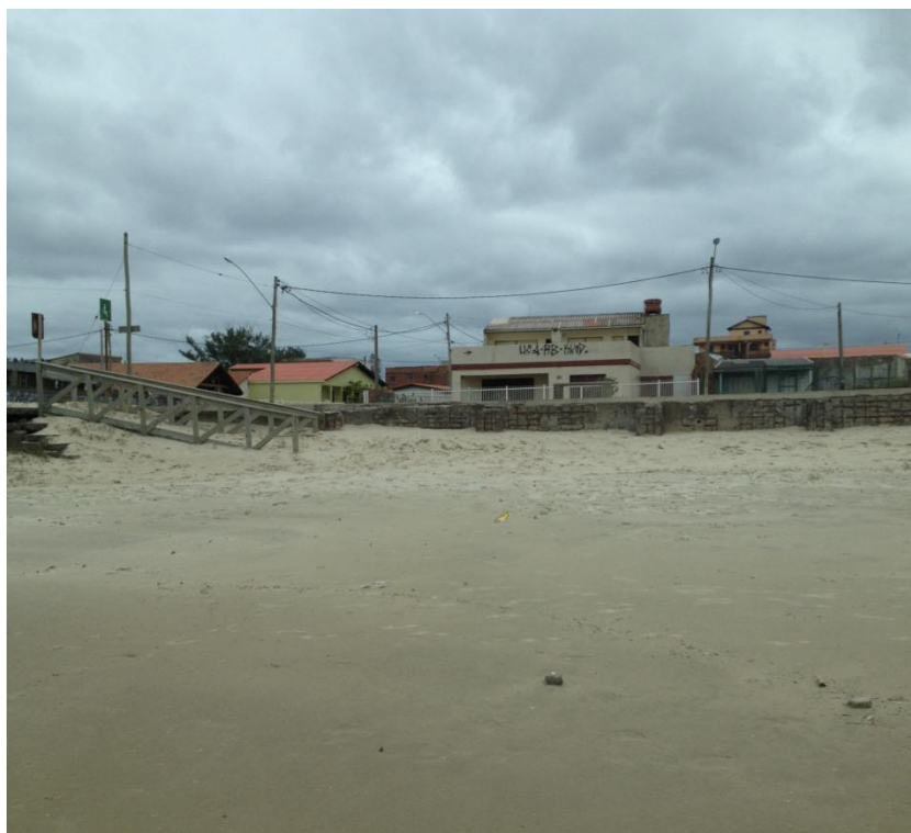
Figura 2: Foto mostrando a altura do pacote vertical de sedimentos acumulados junto ao calçadão.
