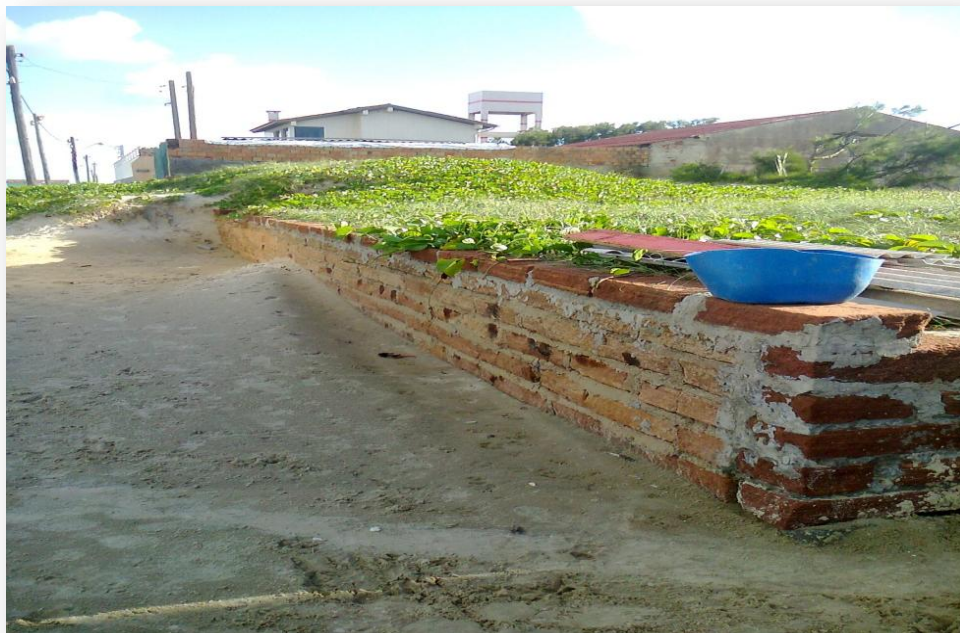
Figura 7: Representação do acúmulo sedimentar no pacote vertical. Fonte: proprietário do imóvel
