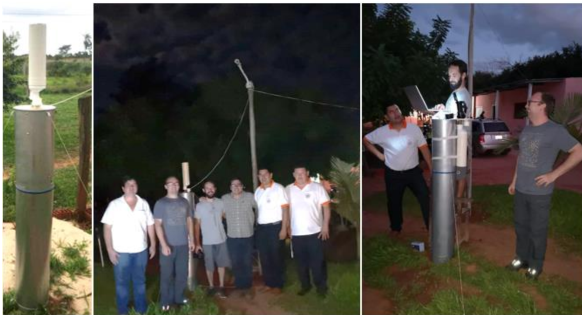
Figura 32. Equipamento instalado em Santa Rosa de Aguaray, São Pedro, Paraguai.
