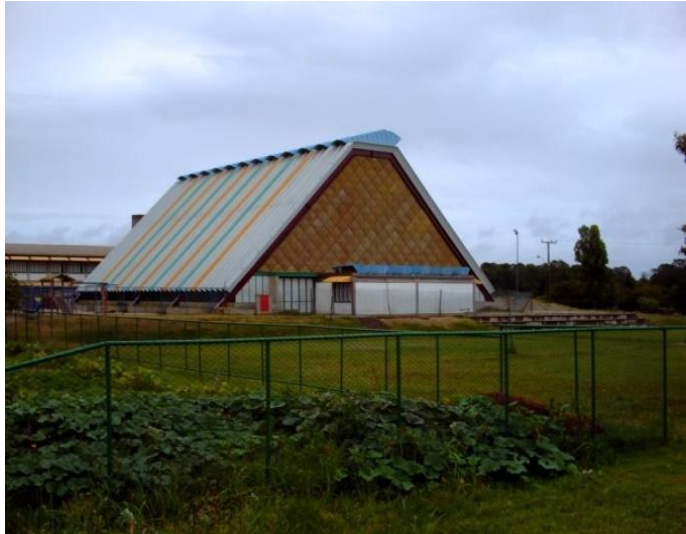
Figura 8 – Prédio do CAIC/FURG
