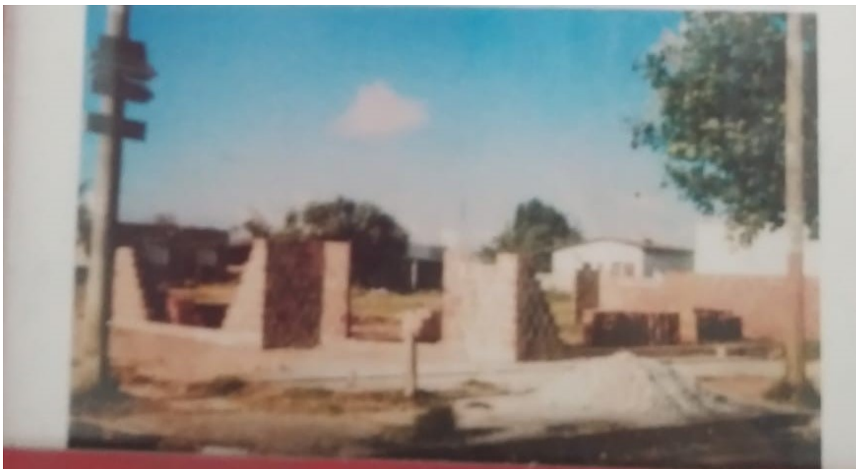
Figura 4 – Obras de construção da associação
