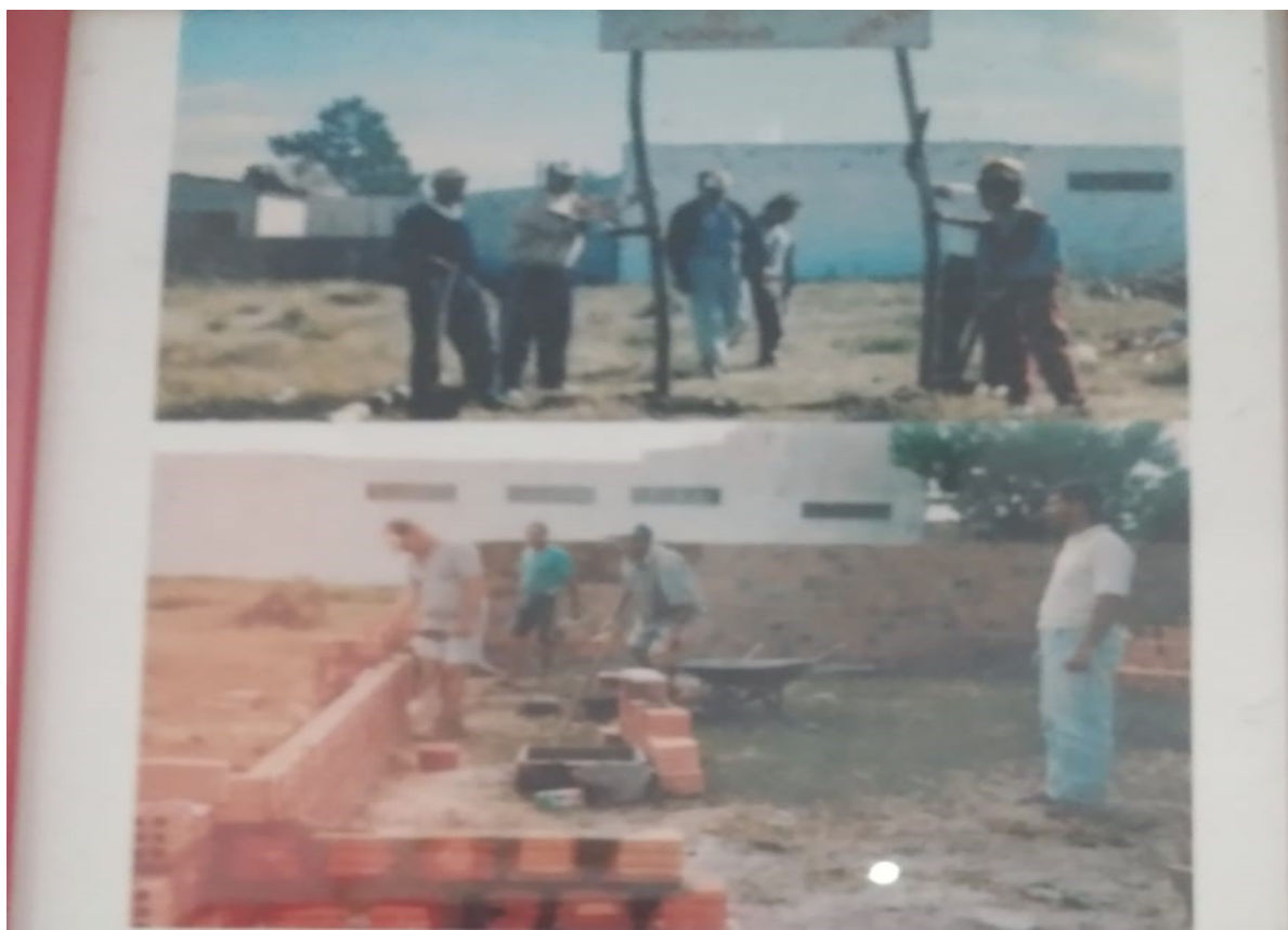
Figura 5 – Obras de construção da associação
